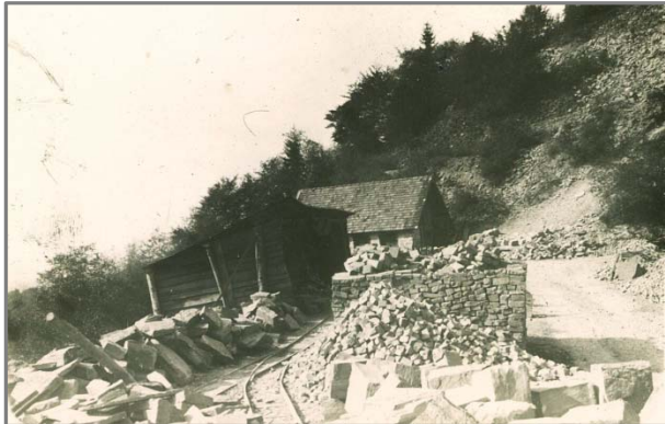
Abb.19 Troll-Steinbruch mit „Rutschern“ und „Brocken“ im Vordergrund
